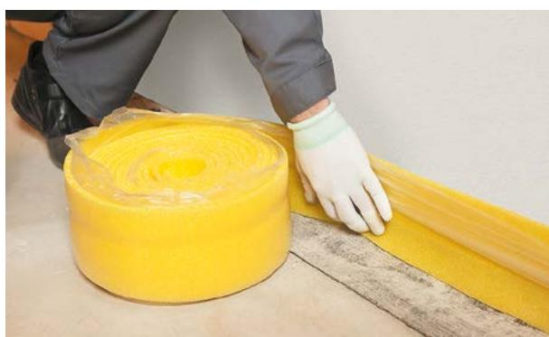
Лента наклеивается на нижнюю часть выровненной и отштукатуренной стены. Клеят ленту по всему períметру помещения, сплошным полотном, без пропусков.
